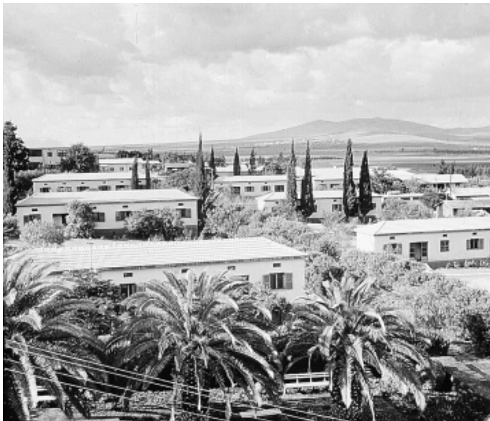
בנייני מגורים בבית-אלפא. מעל לחלונות פתחי אוויר. תצלום מראשית שנות השלושים (התארוך בסיוע מאירה הכהן, ארכיון בית-אלפא)
